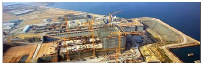
The Adriatic LNG terminal under construction
